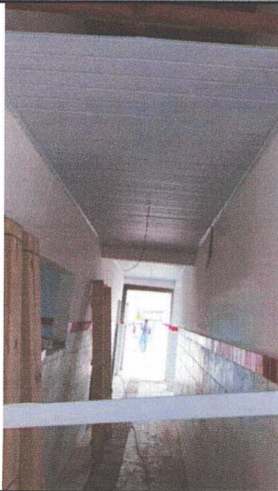
DESCRIÇÃO FORRO; INSTALAÇÃO ELÉTRICA
