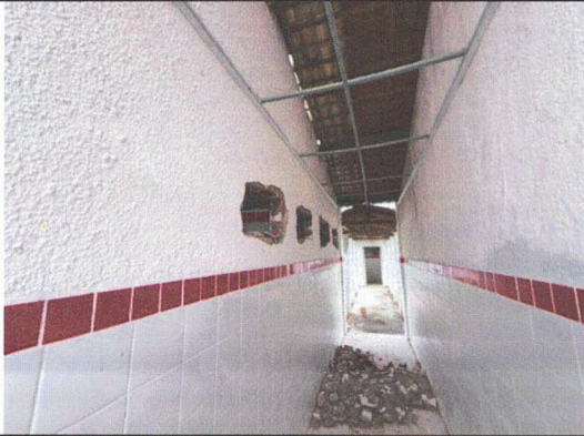
DESCRIÇÃO DEMOLIÇÃO; ESTRUTURA FORRO PVC
