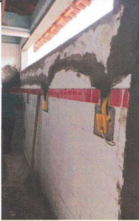
DESCRIÇÃO INSTALAÇÃO ELÉTRICA
