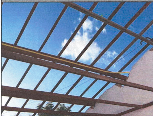
DESCRIÇÃO Remoção, lavagem, carga e retelhamento de telhas cerâmicas tipo canal comum
