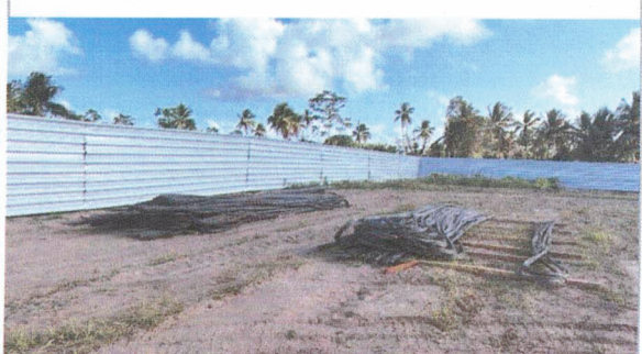
TAPUME (Coordenadas, comentários, etc.)
