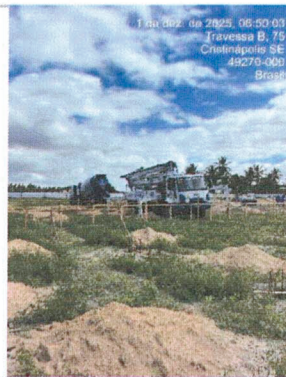
GABARITO; CAMINHÃO COM CONCRETO (Coordenadas, comentários, etc.)
