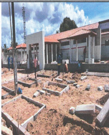
DESCRIÇÃO EXECUÇÃO DE RADIER
